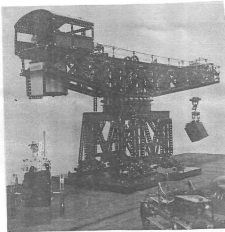
Wes Dalefield - Blocksetting Crane.
